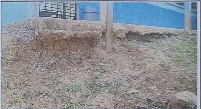
Foto 4: Se observa el piso del corredor de la escuela en el aire que va fragmentandose por el tiempo para ello (Construccion de muro de contencion minimo 25 metros de largo y 1.25 metros de altura)
